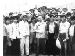
③1958年周恩来总理视察怀柔水库建设工地
