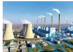
内蒙托克托燃煤火力发电站
