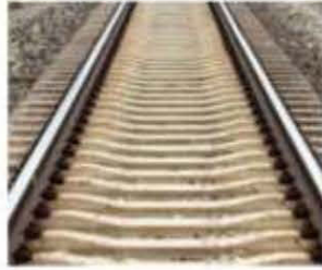
在铁轨下面铺枕木
