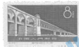
武汉长江大桥
