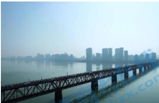
A.钱塘江大桥
